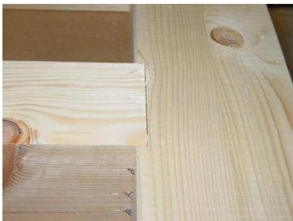
Abb. 8 - Einfräsungen der horizontalen Bauteile
