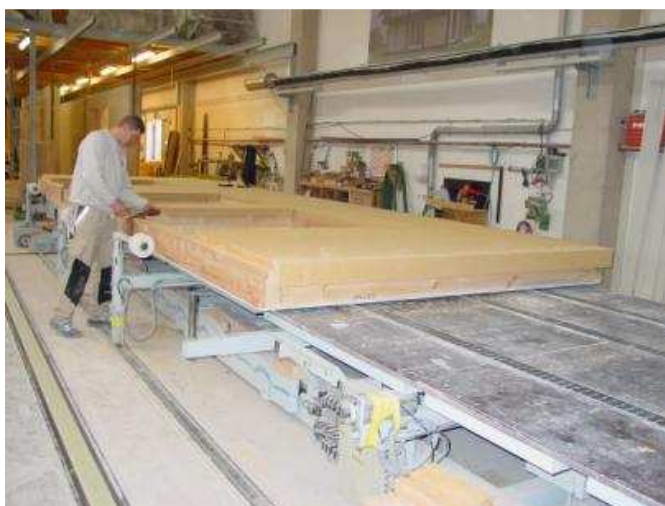
Abb. 11 - Aufbringen der Holzwolle-Leichtbauplatten
