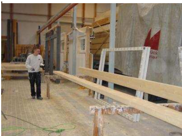
Abb. 14 - Bearbeitung der Konstruktionshölzer vor dem Lackieren
