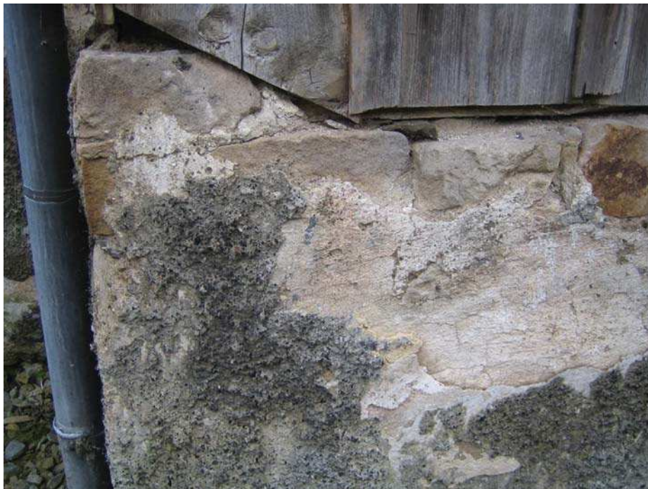
Abbildung 73: Geschädigter Schwellenbereich
