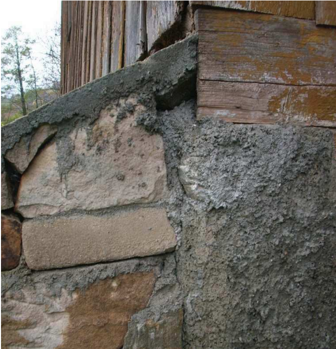
Abbildung 86: Mauerwerksvorlage
