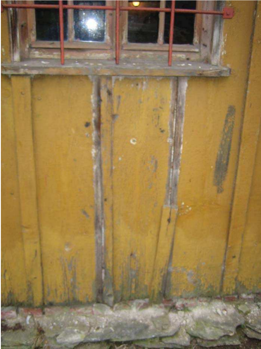
Abbildung 76: Schadhafte Schalung
