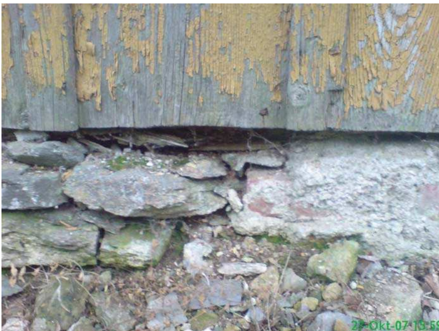
Abbildung 84: Unterschiedliche Sockelmaterialien (Sandstein und Ziegelstein)
