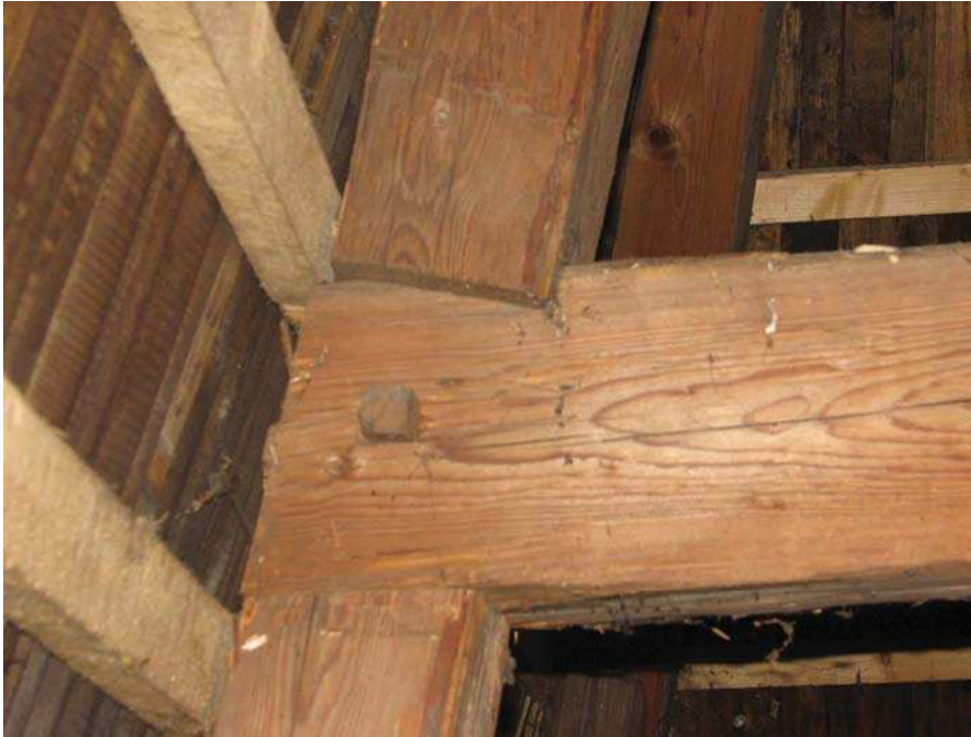
Abbildung 43: Anschluss Kehlbalken an Sparren
