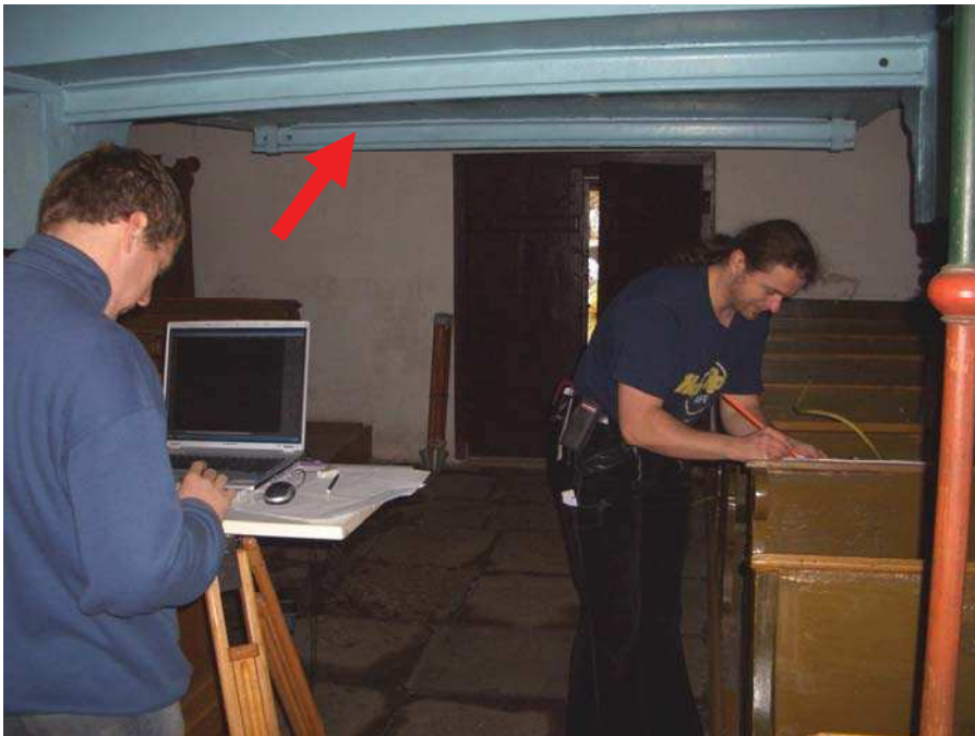
Abbildung 54: Bahnschienen zur Verstärkung der Empore
