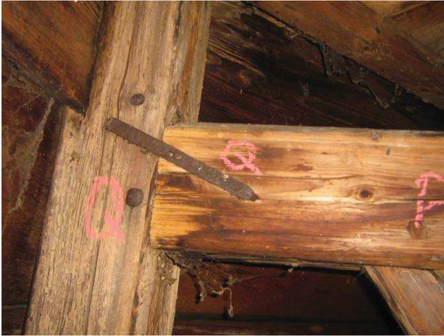
Abbildung 44: Lagesicherung der Bauteile durch metallische Verbindungsmittel
