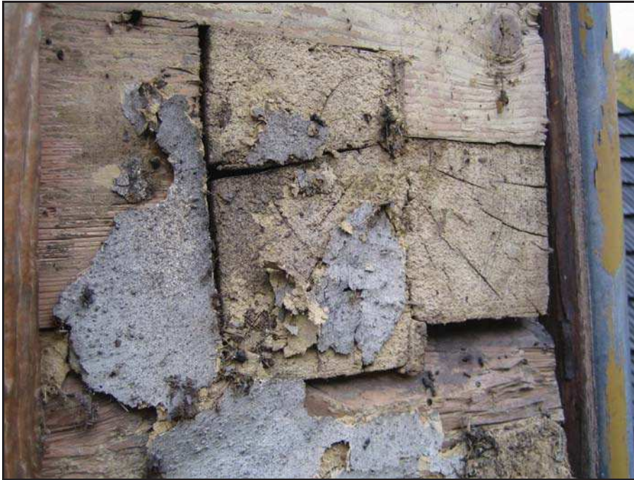
Abbildung 8: Putzrückstände
