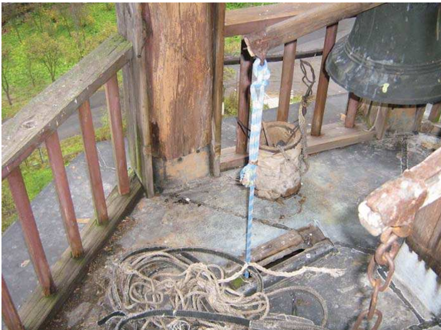
Abbildung 38: Stahlblech-Abdeckung der Plattform
