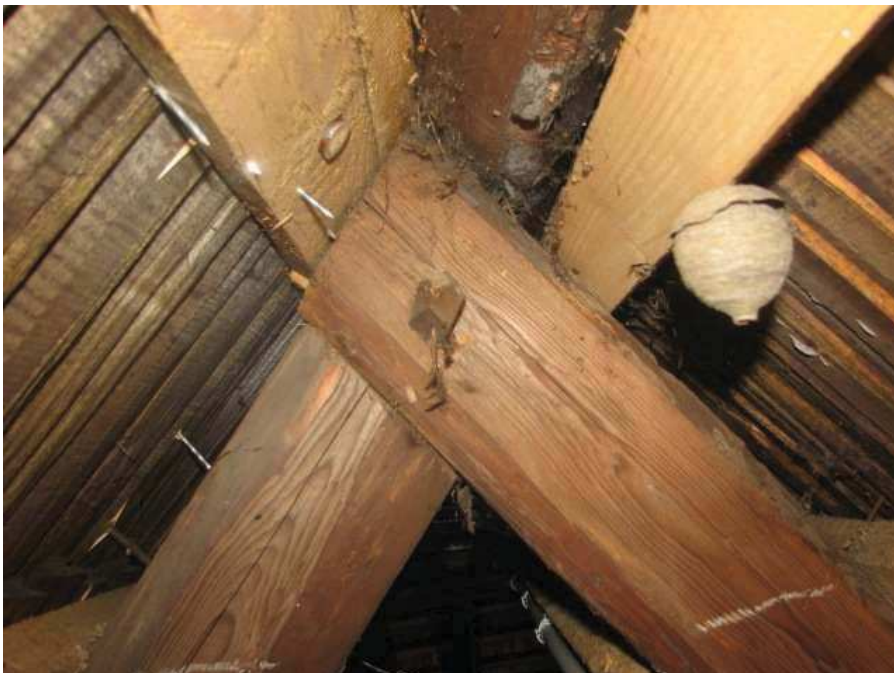
Abbildung 42: Holzverbindung am Firstpunkt
