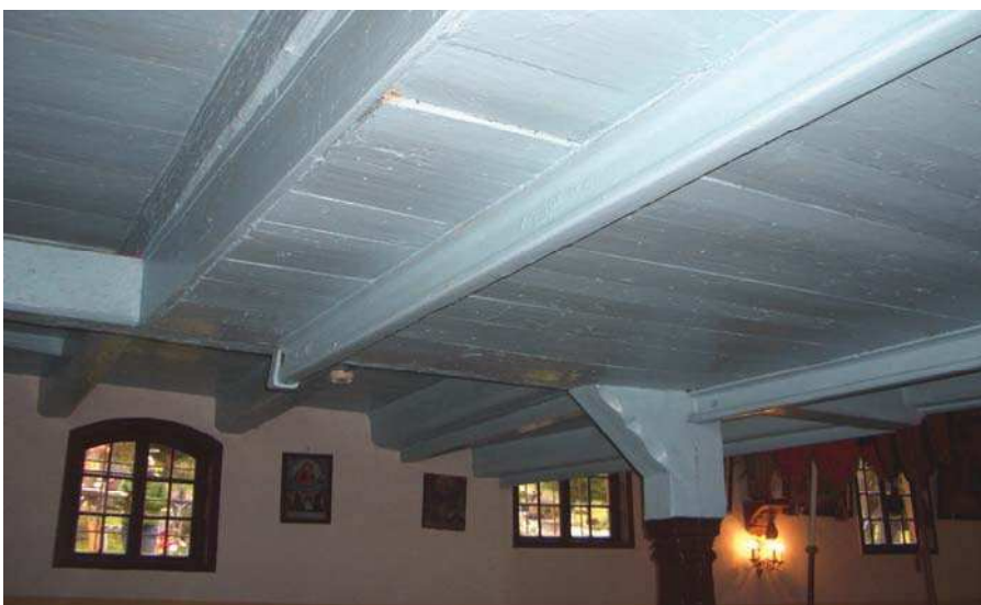
Abbildung 56: Fenster im Bereich der Galerie
