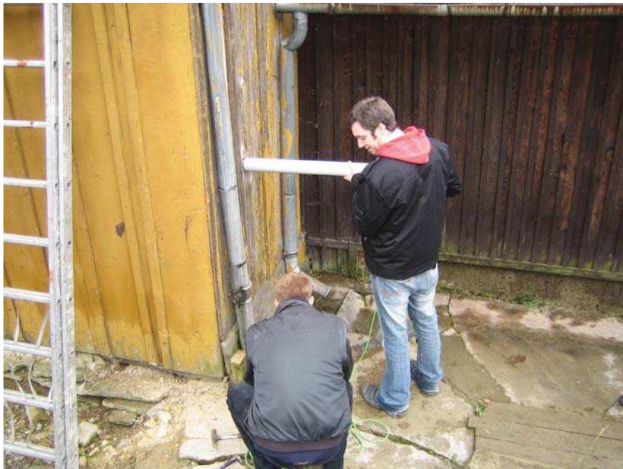
Abbildung 16: Durchführung der Bohrwiderstandsmessung
