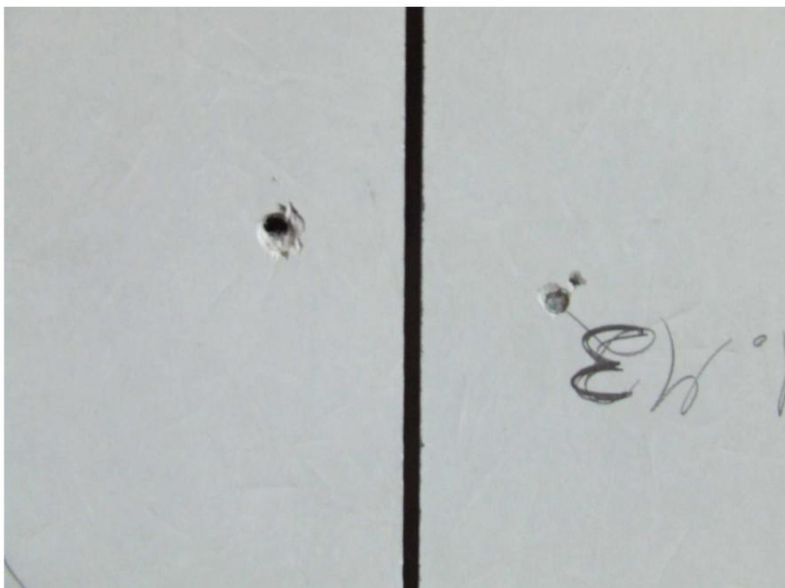
Abbildung 26 Versagen durch Kopfdurchziehen
